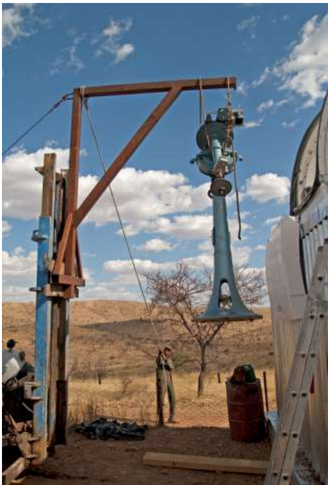
Abb. II.62 Das Einsetzen der Zeiss-Säule gestaltet sich fast ebenso kritisch wie das Aufsetzen der Kuppel
