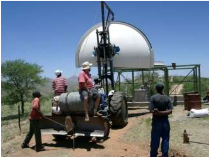
Abb. II.53 Alle verfügbaren Gegengewichte mussten zur Stabilisierung des umgebauten Traktors eingesetzt werden
