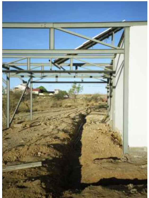
Abb. II.17 Verlegung des Ringerders mit Anschluss an den Stahlrahmen des Gebäudes
