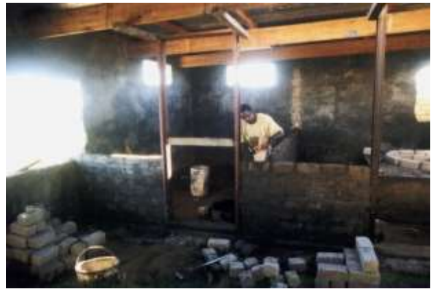
Abb. II.4 Die Wände der Innenräume werden gemauert. Der Sockel für die Säule der Liebscher-Montierung ist rechts zu sehen
