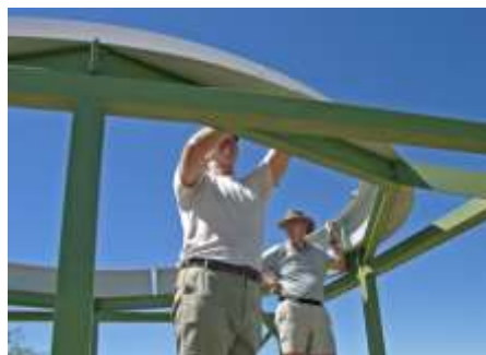
Abb. II.50 Der Stahlrahmen ist fertiggestellt und es kann mit der Montage der Kuppel begonnen werden
