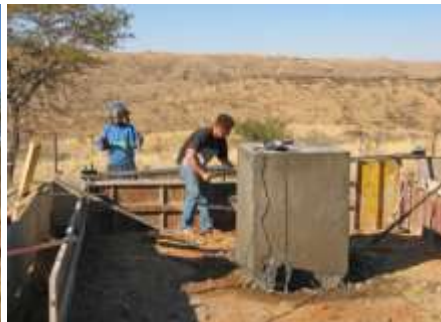
Abb. II.48 Betonarbeiten für den Sockel
