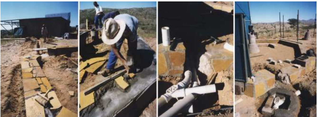
Abb. II.15 Arbeiten an Fundament und Kabelkanälen
