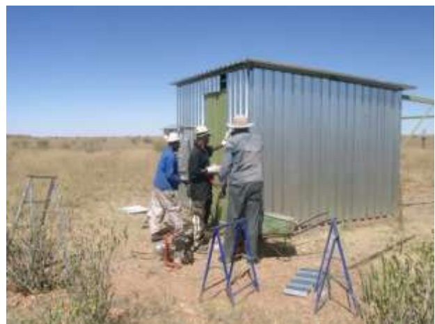
Abb. II.70 Letzte Maßnahmen an der 3-m-Hütte
