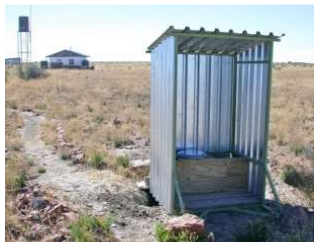
Abb. II.67 Das komfortable Trocken- und Freiluftklo
