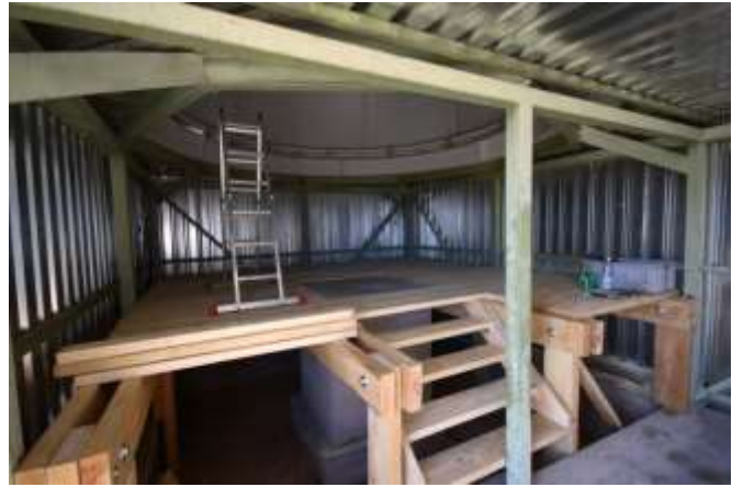
Abb. II.61 Der Zwischenboden ist nahezu fertig
