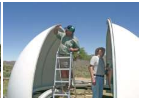
Abb. II.52 Sorgfältiger Zusammenbau und Abdichtung mit Akryl
