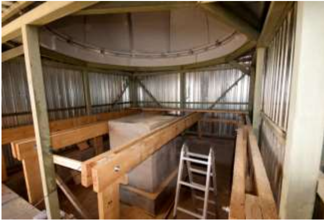
Abb. II.60 Die Tragkonstruktion des Holzbodens
