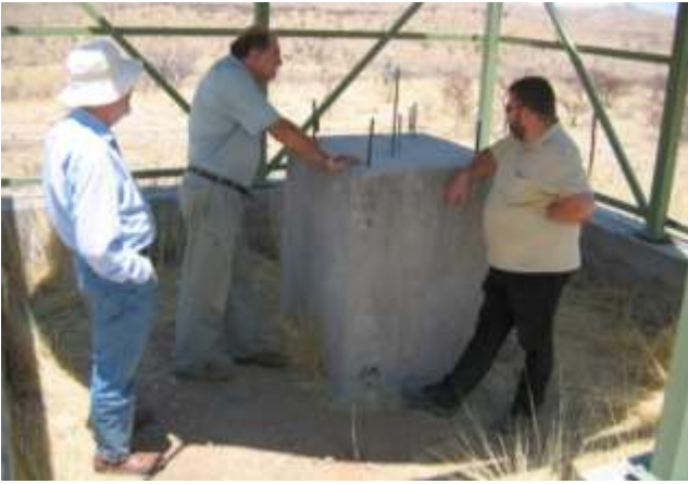
Abb. II.56 Die Anker für Erhöhung und seitliche Ansätze des Sockels sind angebracht
