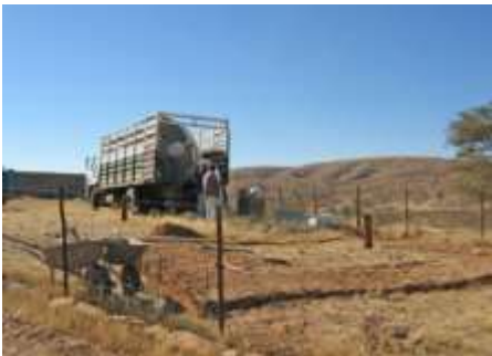
Abb. II.47 Die Gräben für das Fundament sind bereits ausgehoben
