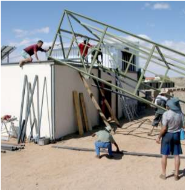
Abb. II.29 Montage des Rolldachs
