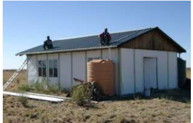
Abb. II.66 Dachrinnen und Wassertanks werden installiert
