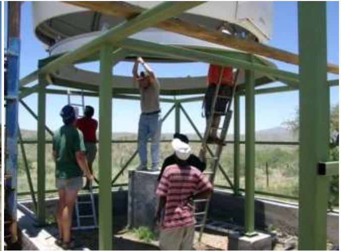
Abb. II.54 Vorsichtig wird die Kuppel mit dem Flaschenzug herabgelassen
