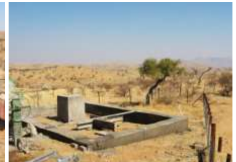
Abb. II.49 Am 22.07.2004 ist der Sockel fertig
