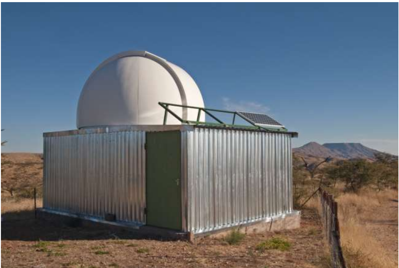
Abb. II.23 Auch das Kuppelgebäude ist bereits mit einem eigenen Solarpanel ausgerüstet
