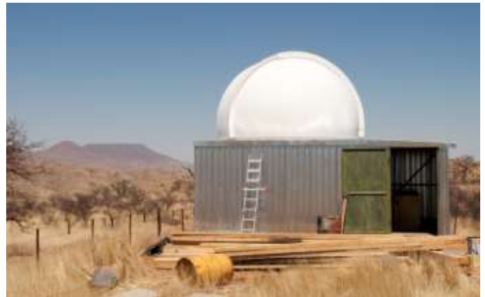
Abb. II.59 Das Kuppelgebäude ist bereit zum Innenausbau
