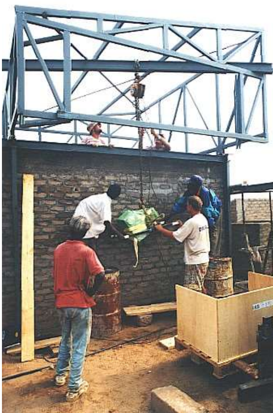
Abb. II.8 Ein spannender Moment: Das kleine Rolldach wird montiert
