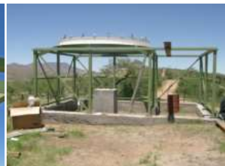
Abb. II.51 Der Laufring für die Kuppel ist bereits aufgesetzt
